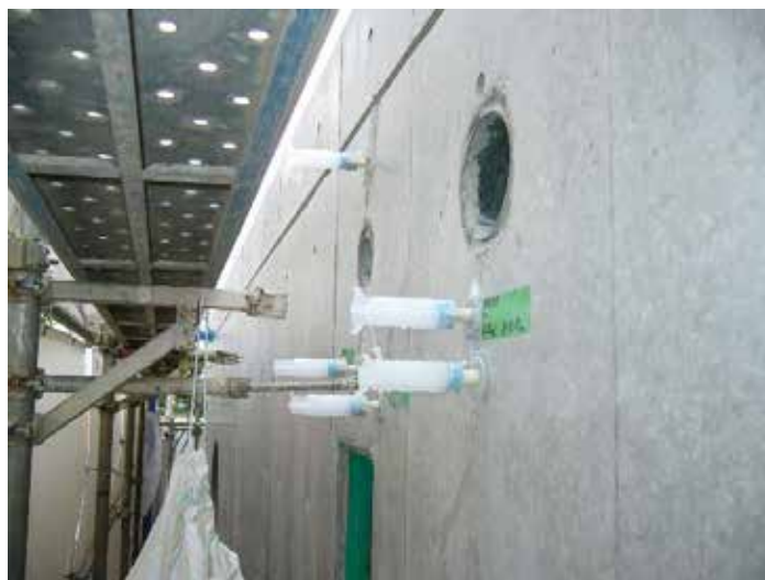
CS-21 注入状況
