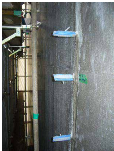
CS-21 注入状況
