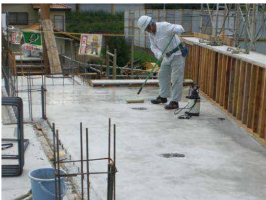
1F 庇：CS-21 塗布状況
