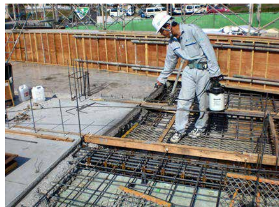
打継ぎ部：CS-21 散布状況
