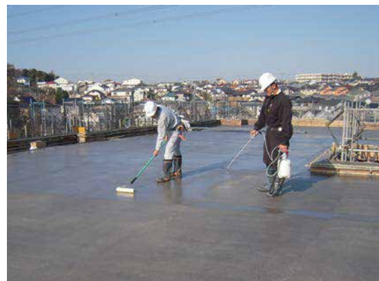
屋上：CS-21 塗布状況
