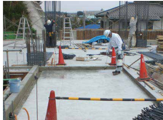
1F バルコニー床：CS-21 散布状況
