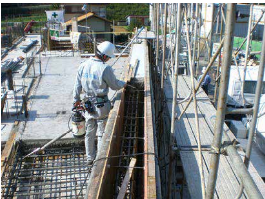
打継ぎ部：CS-21 散布状況
