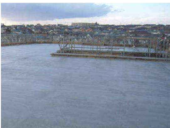
屋上：施工完了
