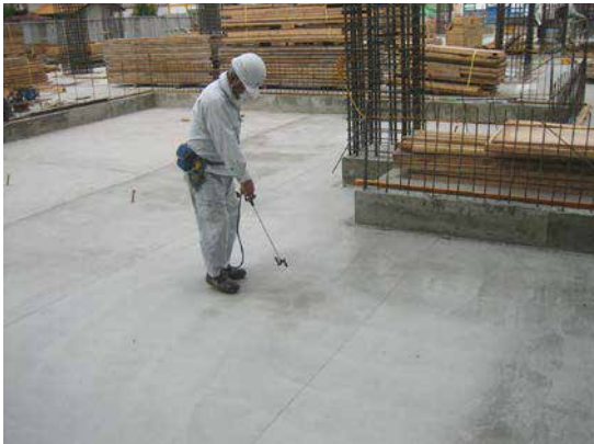
B1 調理室床：CS-21 散布状況
