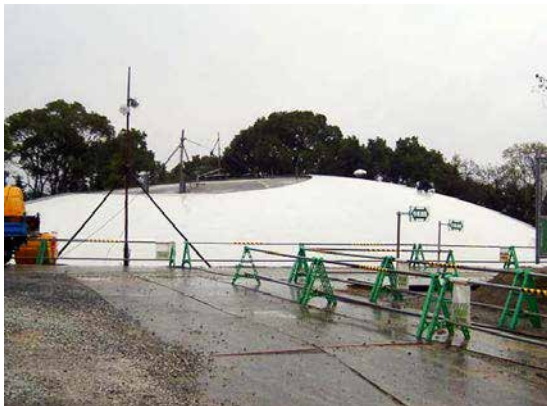
施工箇所全景
