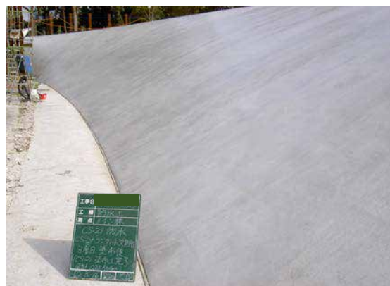
施工完了状況
