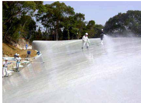
湿潤散水状況
