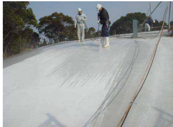
高圧洗浄状況
