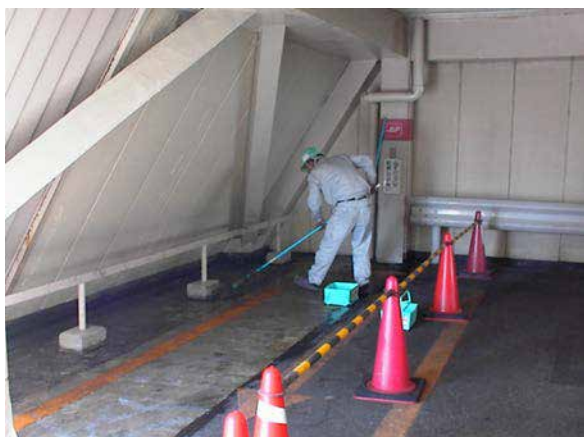
CS-21 塗布状況
