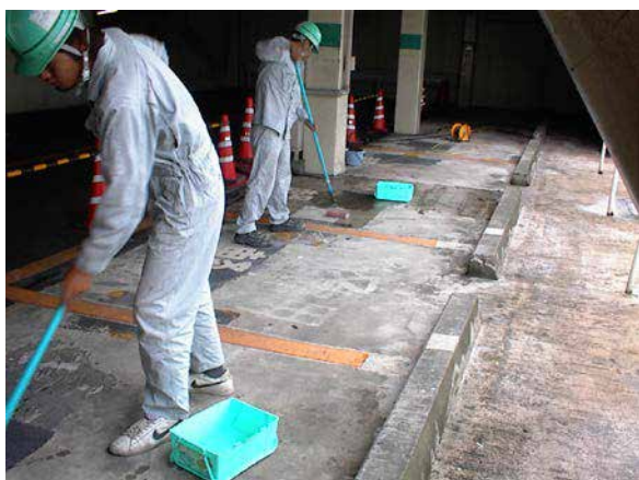
CS-21 塗布状況
