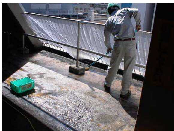
CS-21 塗布状況
