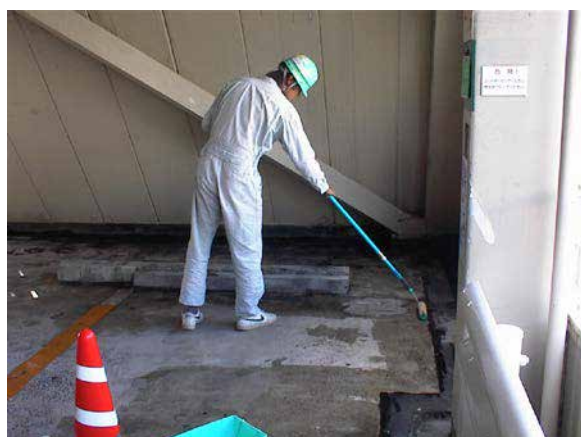
CS-21 塗布状況
