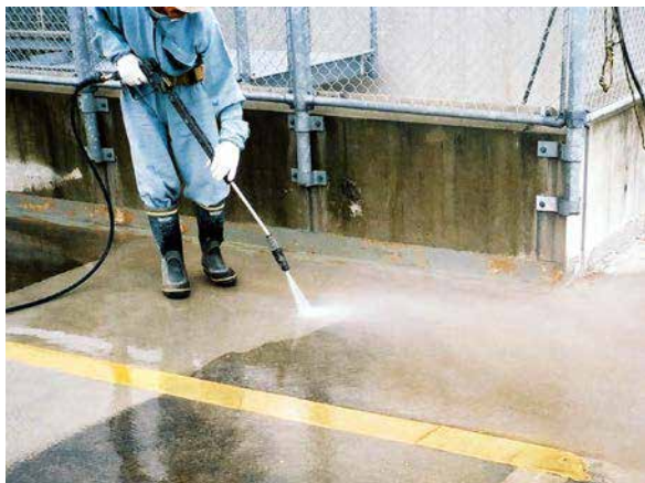
高圧洗浄状況
