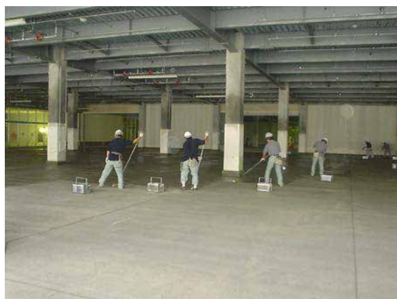
CS-21 塗布状況
