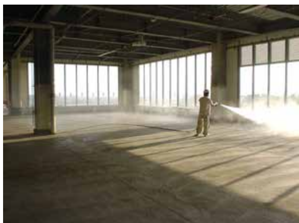
湿潤散水状況
