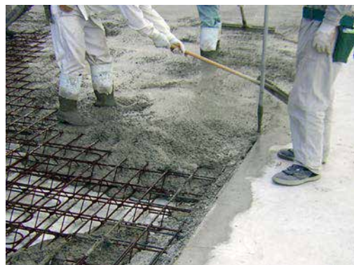
コンクリート打設立会い状況
