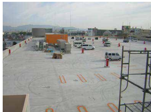
屋上駐車場全景
