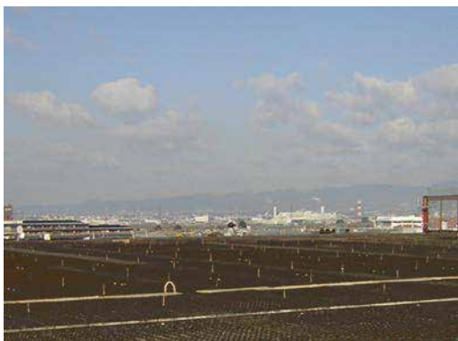
鉄筋検査状況
