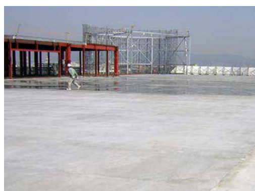
湿潤散水状況
