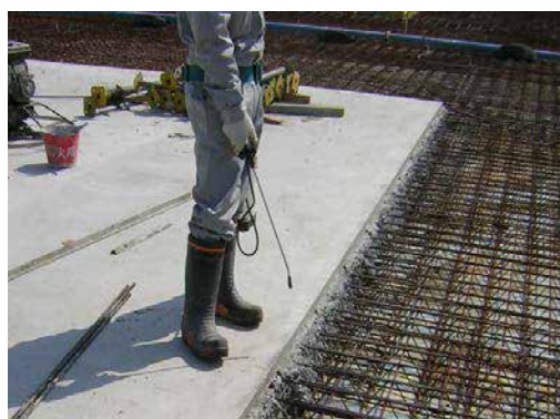
打継ぎ部：CS-21 散布状況
