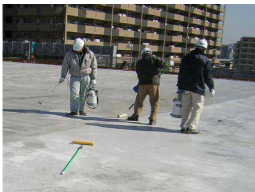
CS-21 塗布状況
