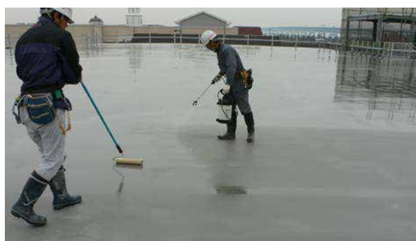
CS-21 塗布状況
